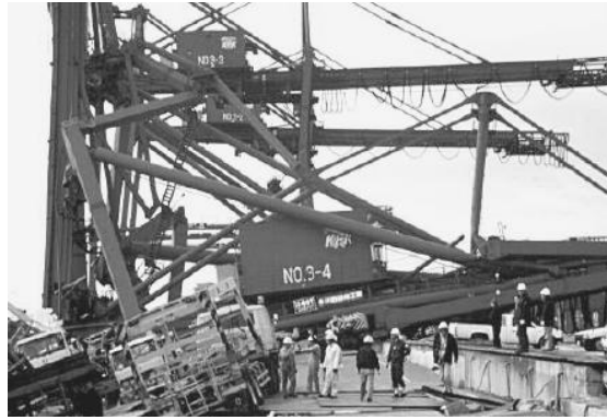
Şekil 1. 1995 Kobe depreminde yıkılan bir konteyner kreni (Fotoğraf: C. Scawthorn).
