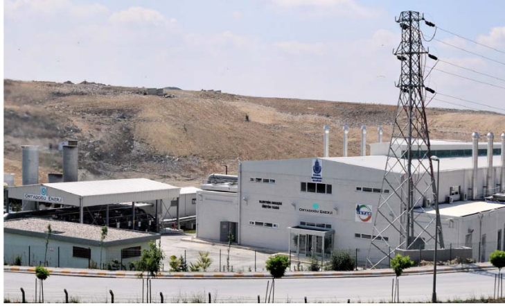
Şekil 7. İstanbul Odayeri Enerji Üretim Tesisi
